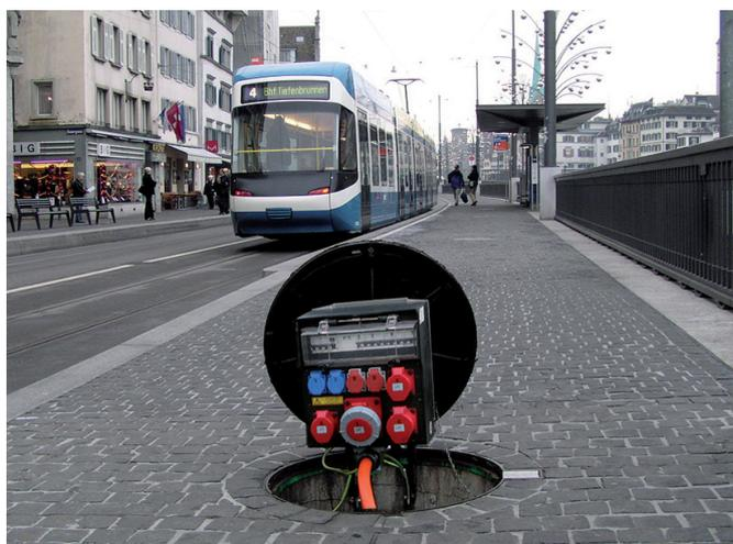
\*1 Questi modelli comprendono uno sportello per l'uscita di cavo in modo da poter chiudere il coperchio durante l'uso. Pertanto, queste strutture sono accessibili e transitabili anche durante il funzionamento.
